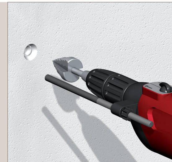
fresatura diametro 16-18 mm
